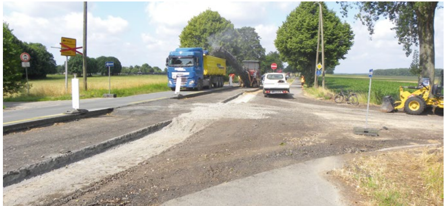
Zwischen Xanten-Birten und Poll rollt der Verkehr wieder: Die Fahrbahnen wurden im Herbst saniert.
