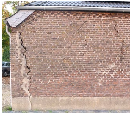
Risse im Mauerwerk – aber kein Bergschaden: Diese Scheunen stehen weit außerhalb des Nullrandes und damit nicht im Einwirkungsbereich des ehemaligen Salzbergbaus.
