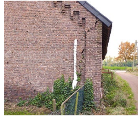
Risse im Mauerwerk – aber kein Bergschaden: Diese Scheunen stehen weit außerhalb des Nullrandes und damit nicht im Einwirkungsbereich des ehemaligen Salzbergbaus.
