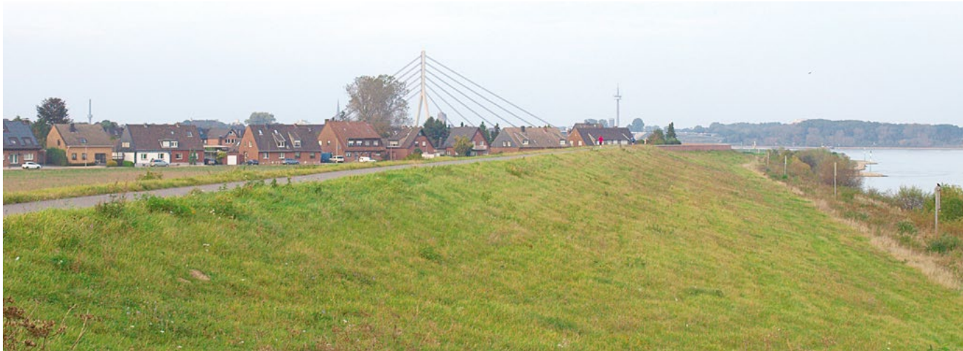
Höhere Anforderungen an den Hochwasserschutz wurden in Wesel-Büderich bereits umgesetzt: im modernen Drei-Zonen-Deich.
