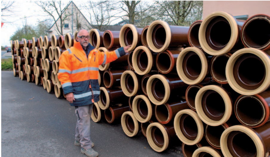
Mit diesen Rohren wird die Kanalisation in Rheinberg-Wallach saniert. Verantwortlich dafür ist Herrmann Boerboom von der Firma Loock.
