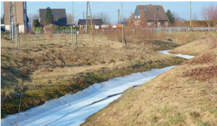
Die „Breite Wardtley“ verläuft im Westen Buderichs. Der Graben wurde 2010 vertieft und verbreitert. Er liegt im Senkungstiefpunkt und kann bei Starkregen als Überflutungssfläche dienen.
