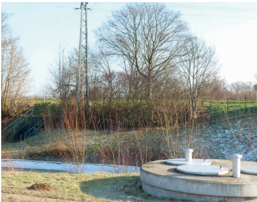
2010 ist nicht nur die Breite Wardtley verlegt und ausgebaut sowie das Rückhaltebecken angelegt worden, das zusätzlich Oberflächenwasser – beispielsweise bei Starkregenereignissen – aufnehmen kann. Es ist außerdem das Bauwerk für die Pumpanlage (rechts) vorbereitet worden, über die Wasser in den Rhein abgepumpt werden kann.
